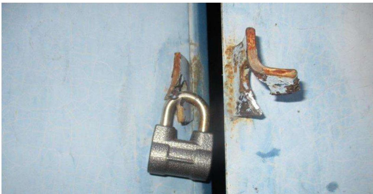
Сломанные проушины дверей ТП.
