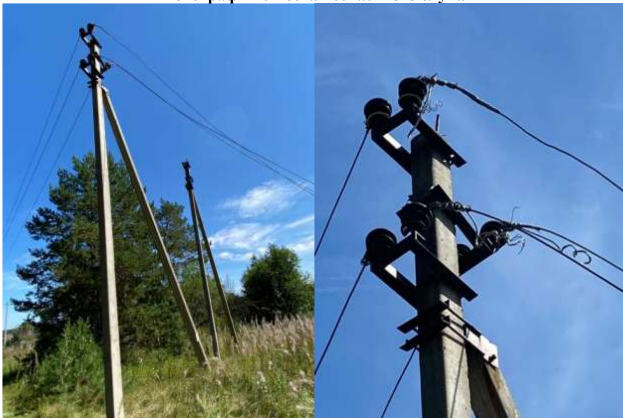
Опора №48 с демонтированными шлейфами.
