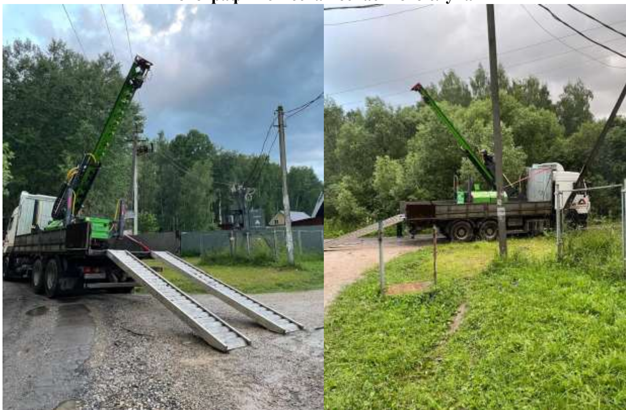
Свае-забойная установка на месте несчастного случая.
